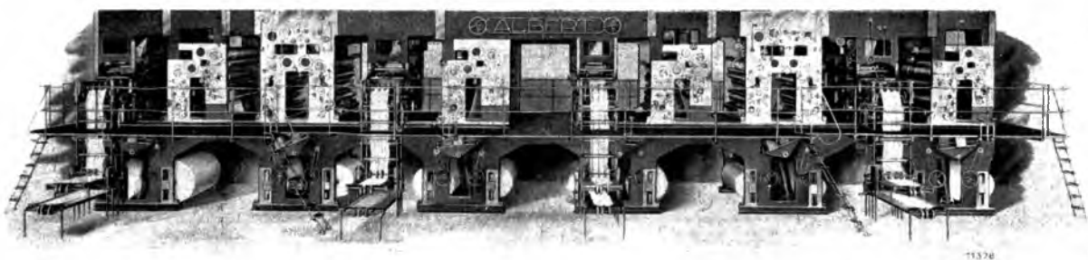
3. ábra. A frankenthali gépgyár háromszor 32 oldalas, soros elrendezésű, gyorsfutó hírlapnyomó körforgógépe
